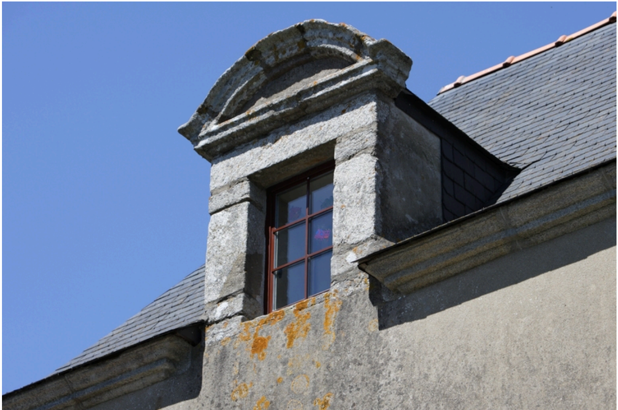
Logis. Façade sud. Détail de la première lucarne.
