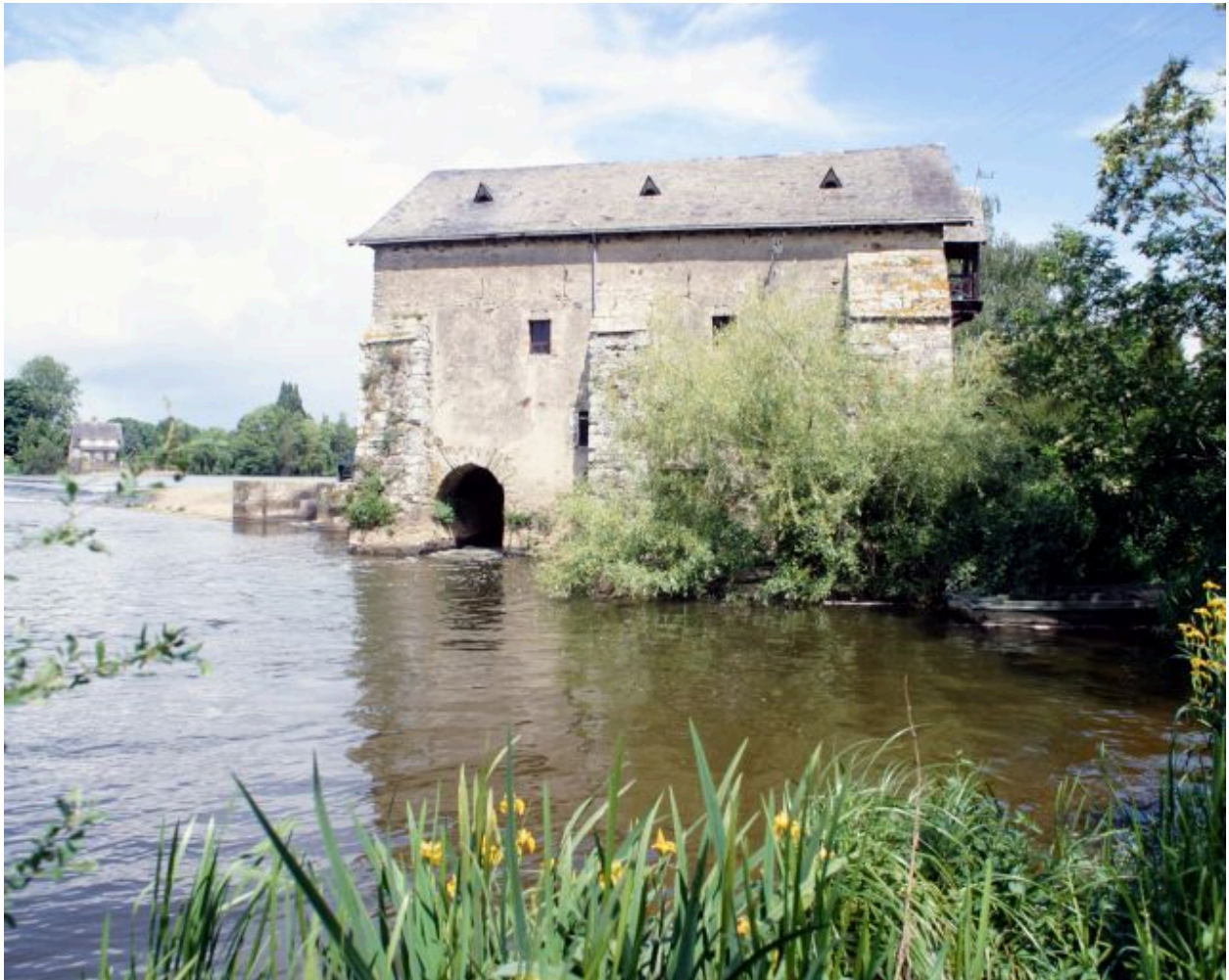
La façade sud et la sortie du coursier du large, vus d'aval.
