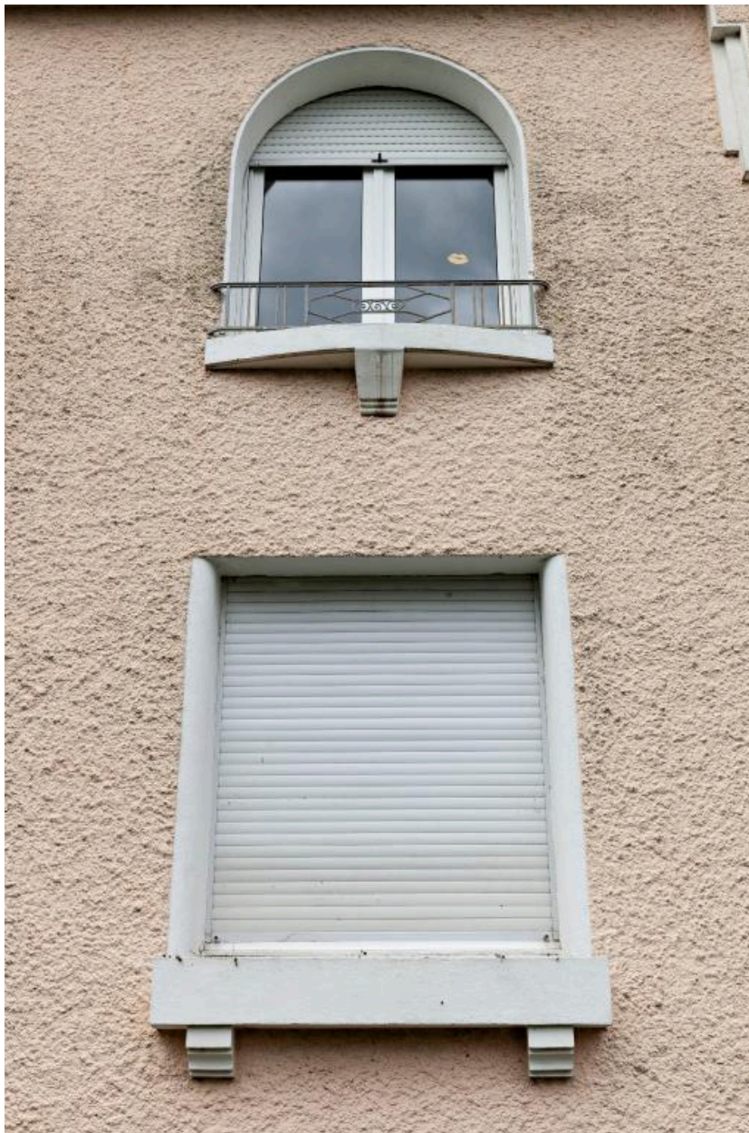
Elévation postérieure, vue des ouvertures.
