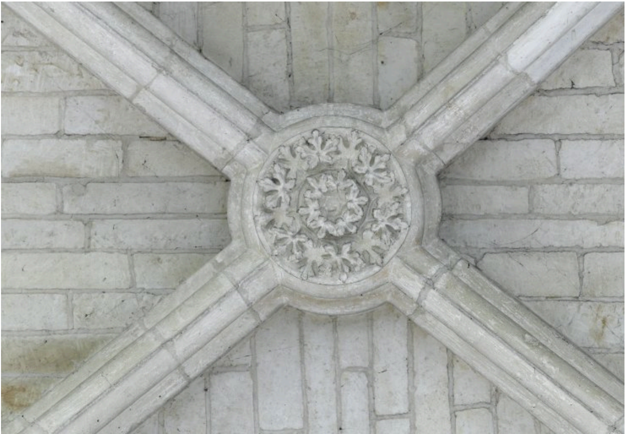
Bas-côté sud de la nef : clef de voûte de la quatrième travée.
