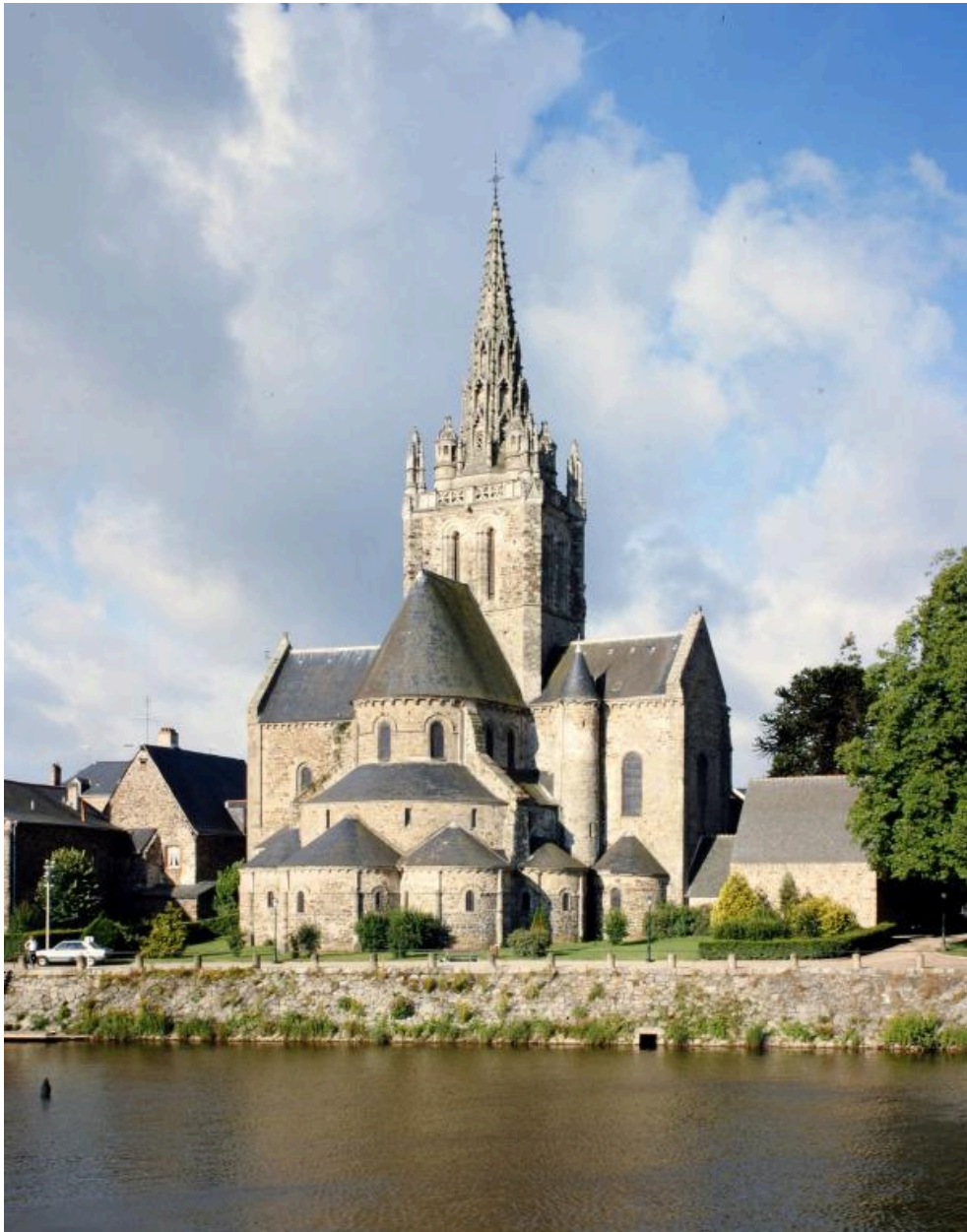
Vue d'ensemble du chevet depuis le nord-est.
