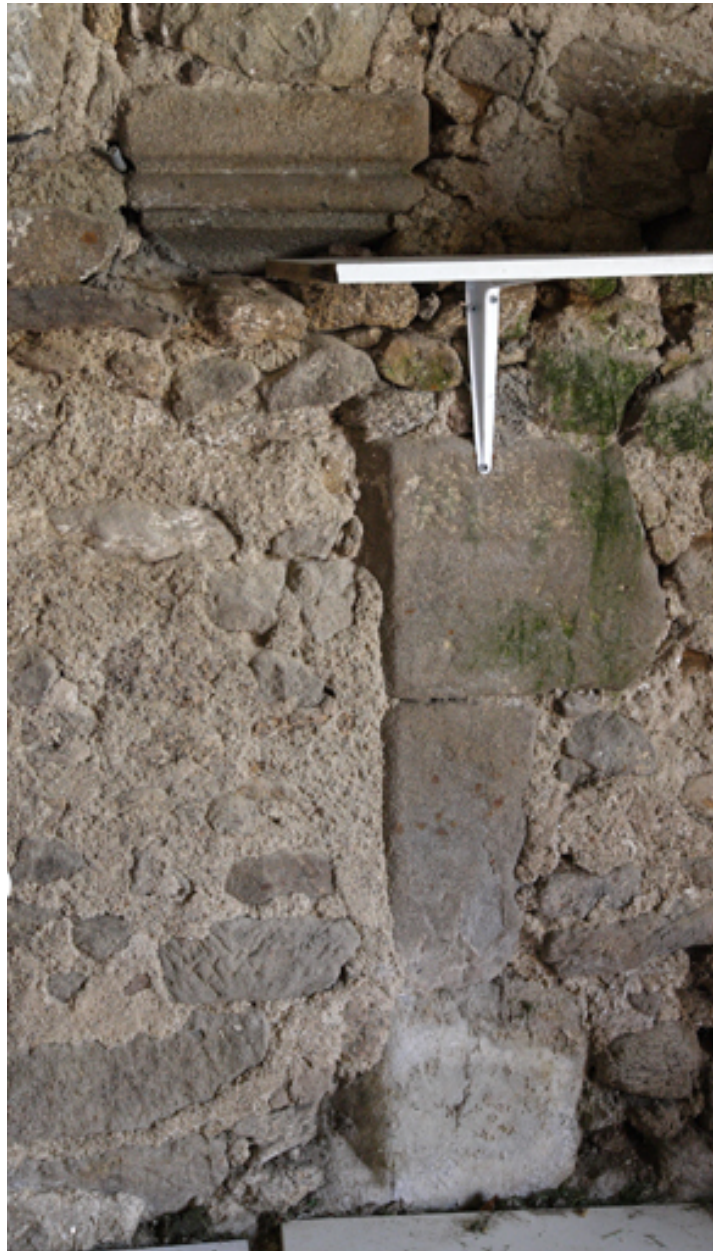
Logis. 1er niveau. Salle est. Piédroit de droite de la cheminée sur le pignon est.
