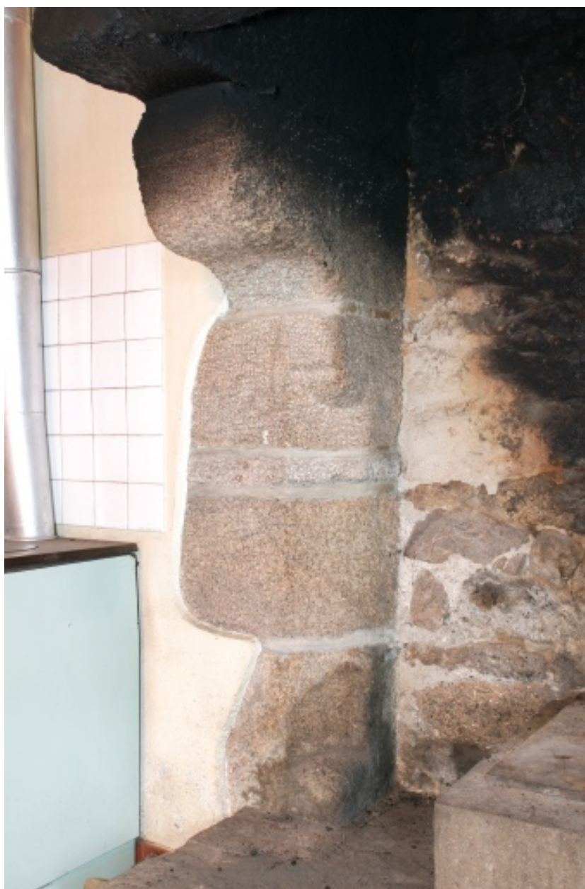
Cheminée, détail du piédroit gauche.
