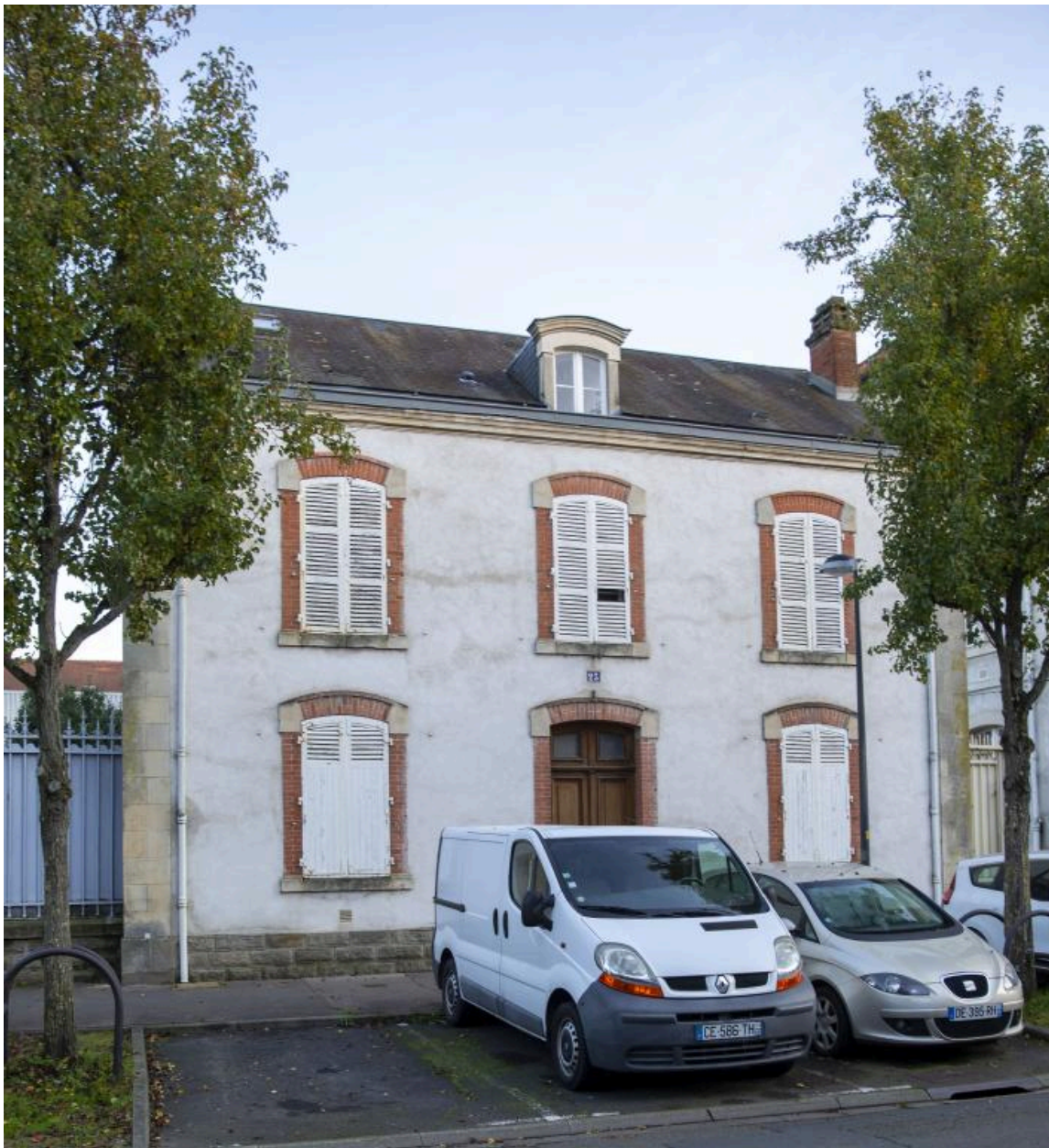
Vue de la façade principale de la maison du gardien depuis la rue du Colonel Raynal.
