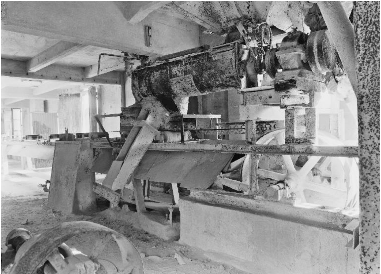
Usine de chaux, plate-forme supérieure des silos ; réception de la chaux
