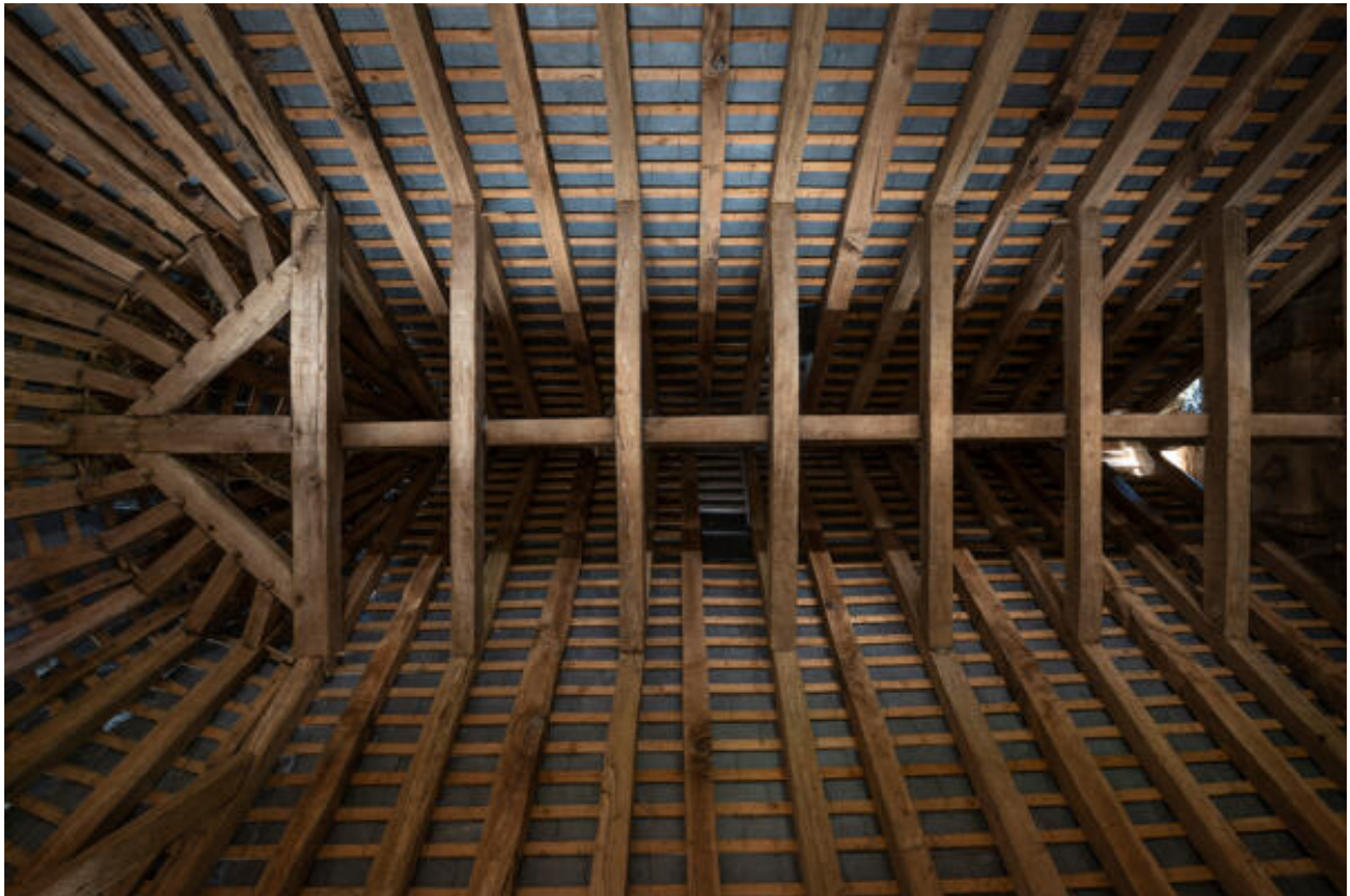
La charpente du bâtiment en abside.
