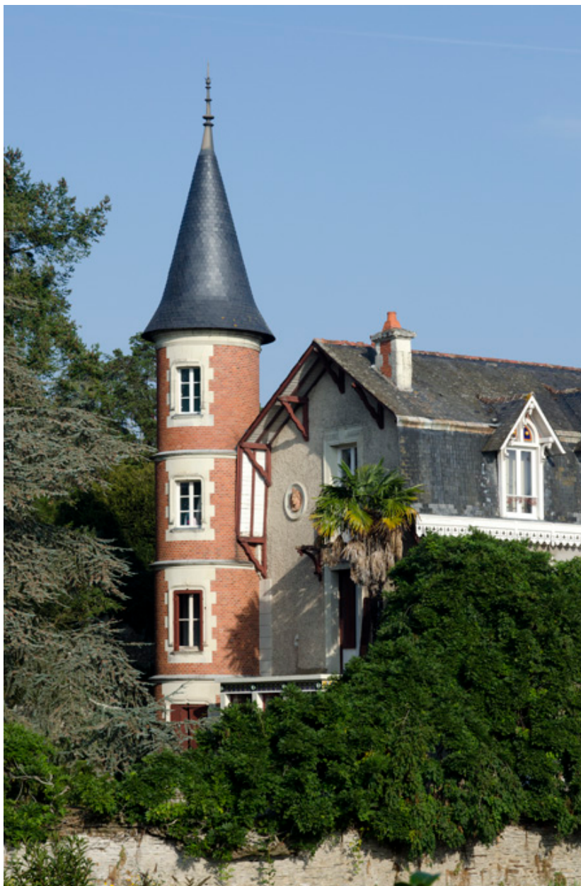
Détail de la tourelle d'angle.
