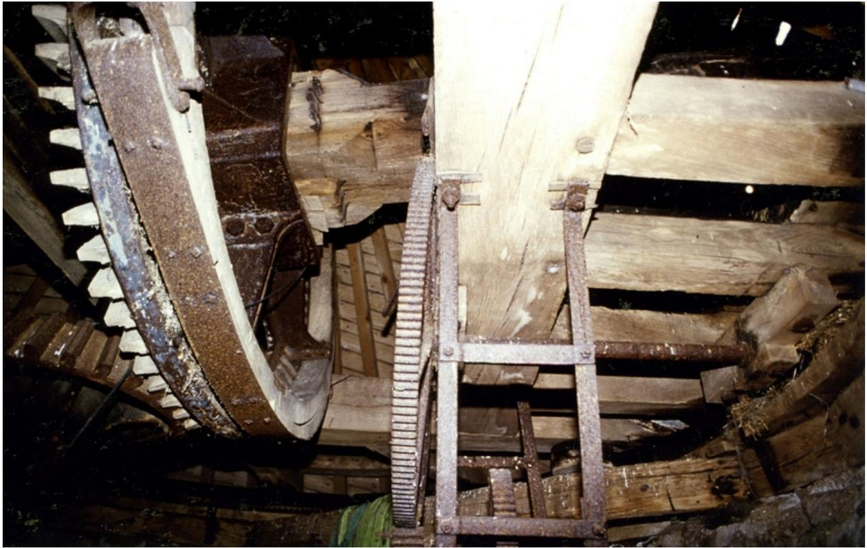
Intérieur de la tour, niveau du comble. Détail du rouet et du treuil de giration de la coiffe.
