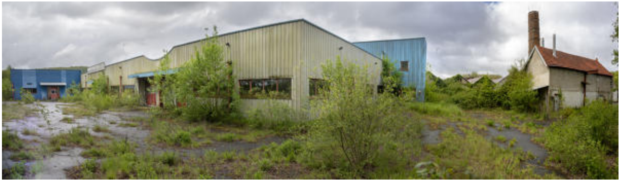
Vue d'ensemble de l'usine depuis le nord.
