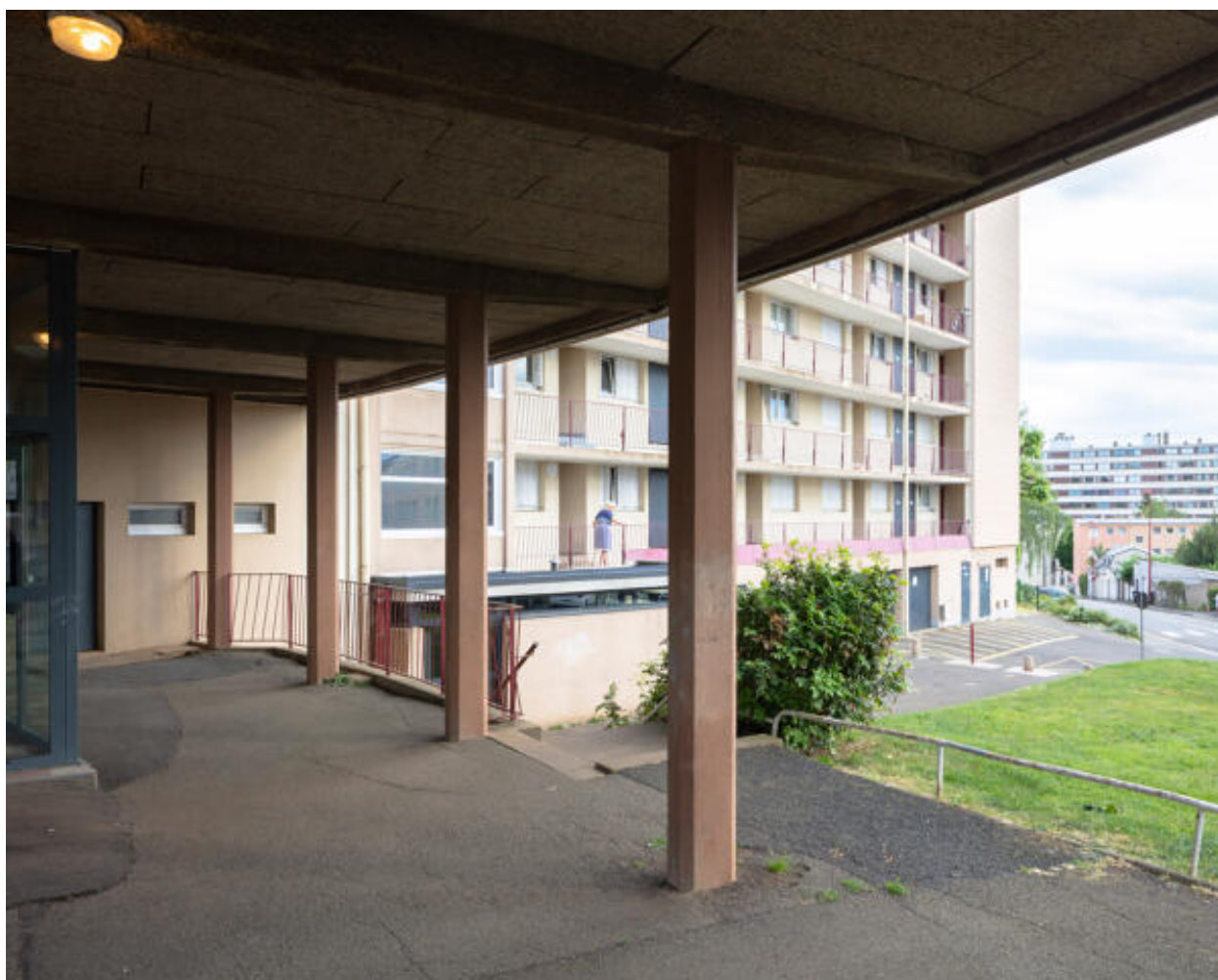
Vue des niveaux inférieurs de la barre de logements depuis le porche menant au bassin central.
