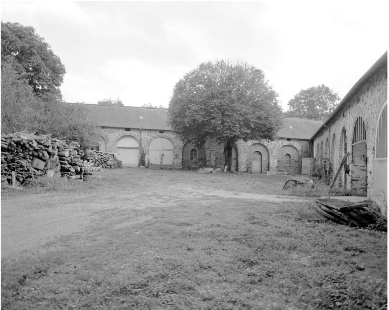
Les dépendances du moulin bordant la cour au sud et à l'ouest.
