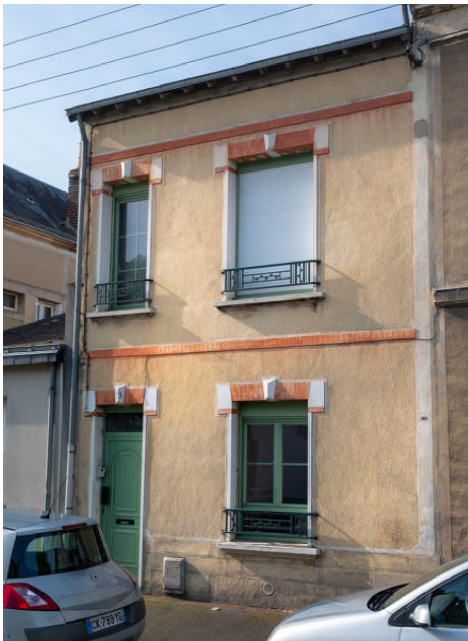
Vue d'une maison économique Levesque avenue Rubillard.
