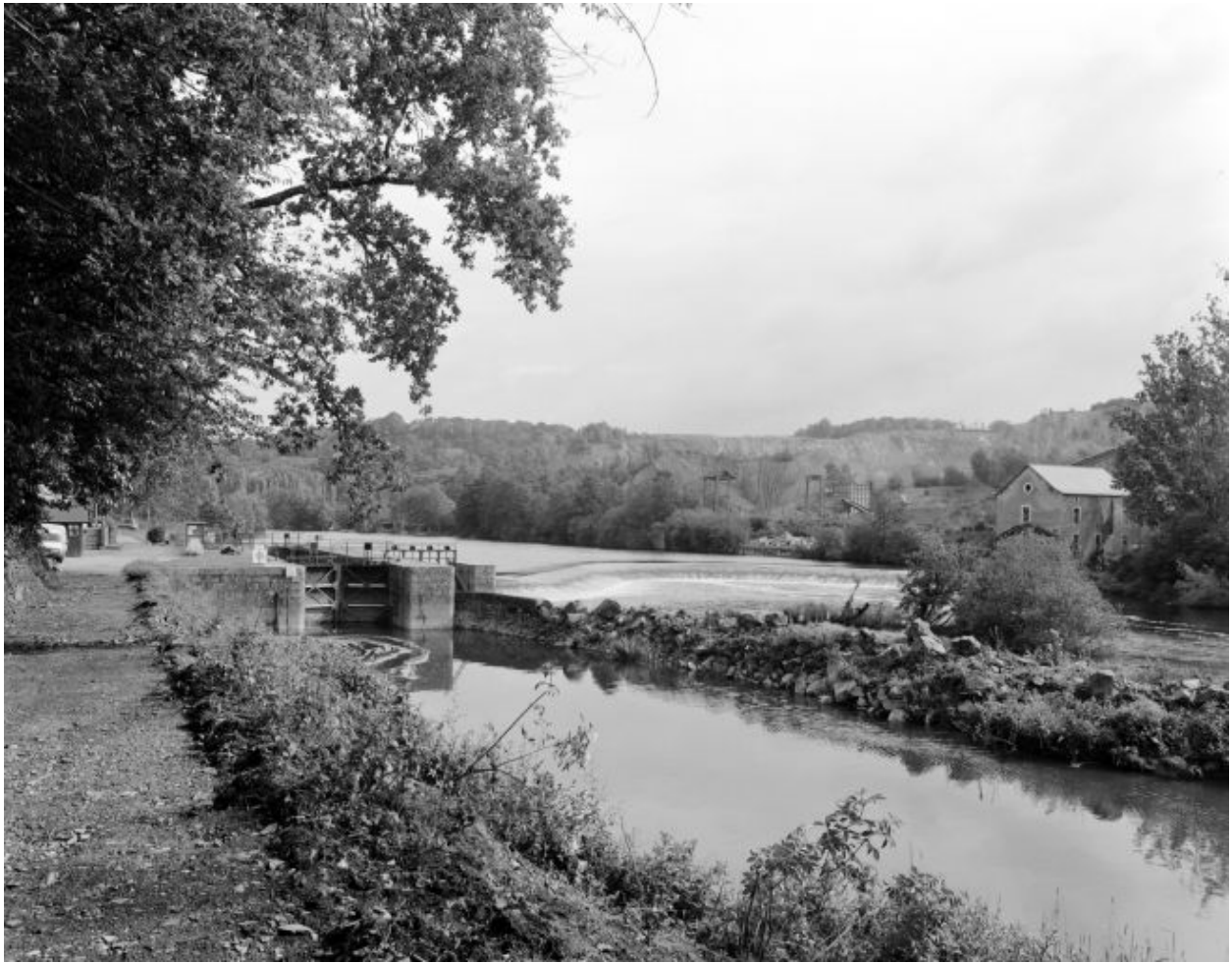
Vue d'ensemble du site depuis la rive droite en aval : écluse, barrage, ancien moulin.
