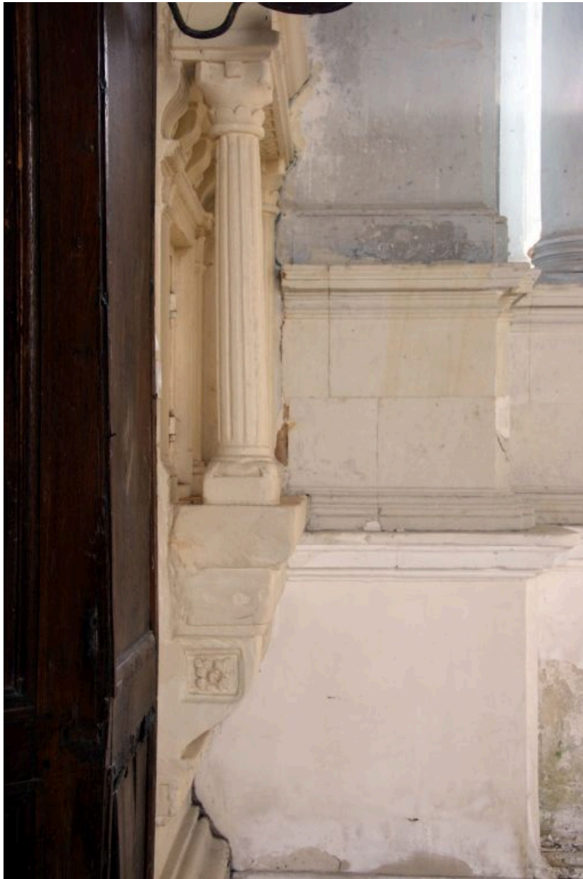
Ancien retable de la Renaissance : profil de la console qui supporte la colonne.
