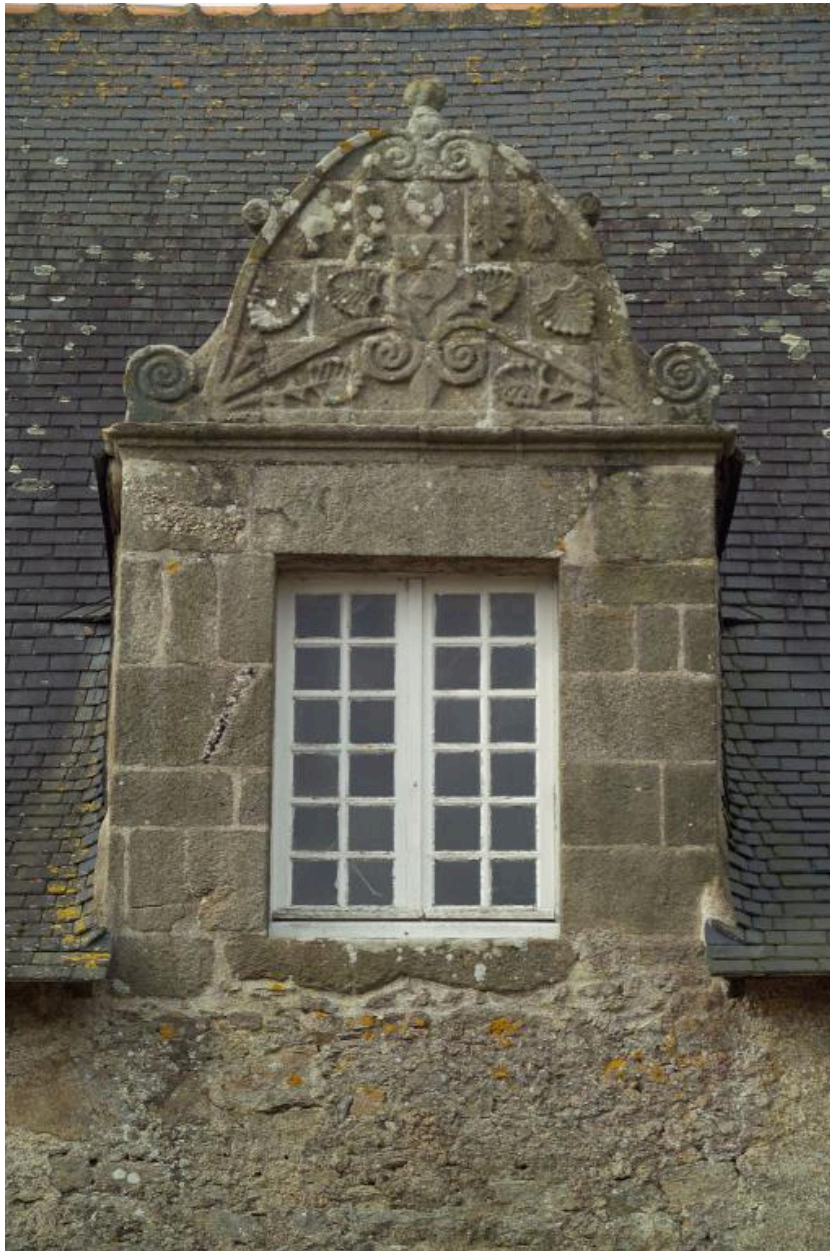
Troisième lucarne à gauche sur l'élévation droite des anciennes écuries.
