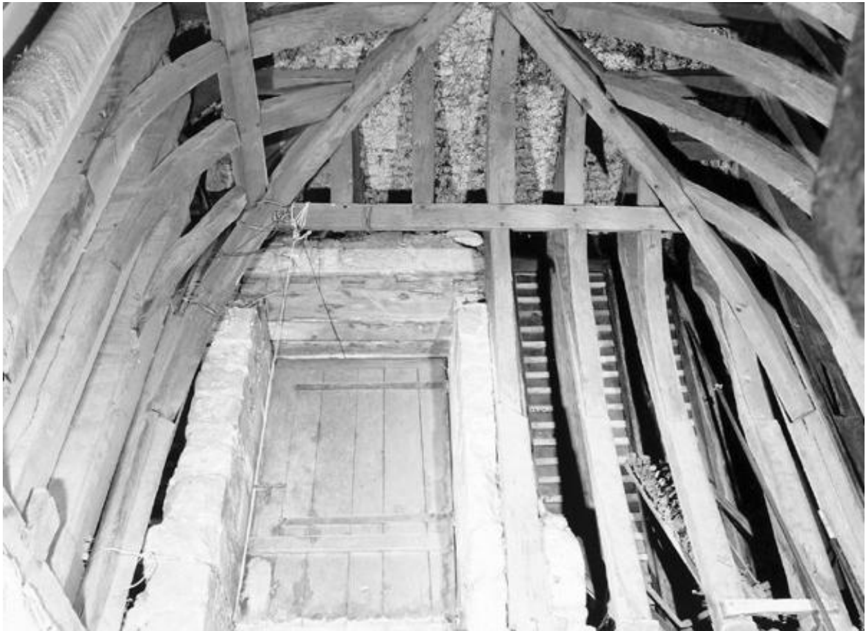
Pavillon sud-ouest de l'abbaye, escalier de service : charpente vers ouest.
