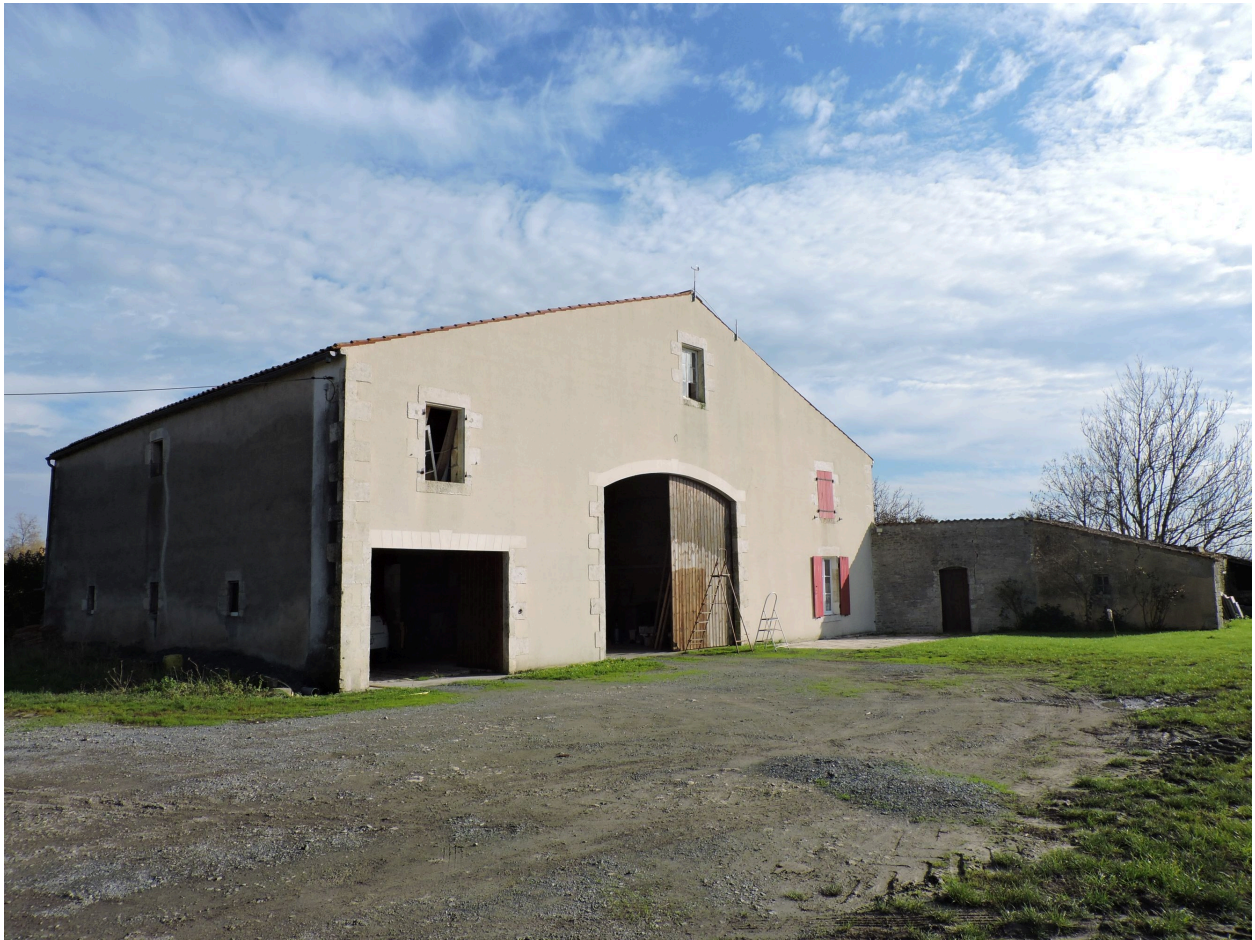
La ferme vue depuis le nord-ouest.
