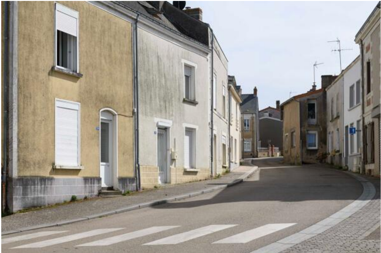
Vue de la rue des Mauges depuis le nord.
