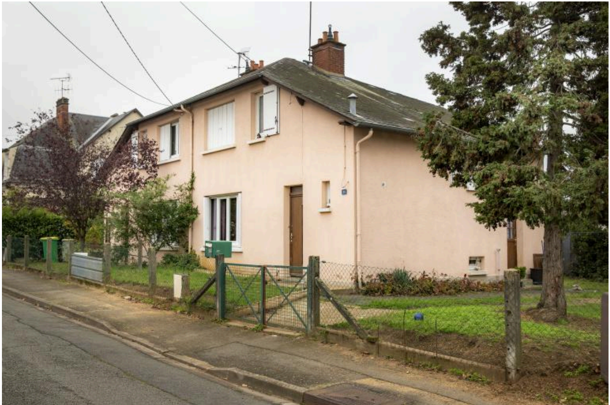
Vue de la façade d'un pavillon double dit Reconstruction rue du Docteur-Roux.
