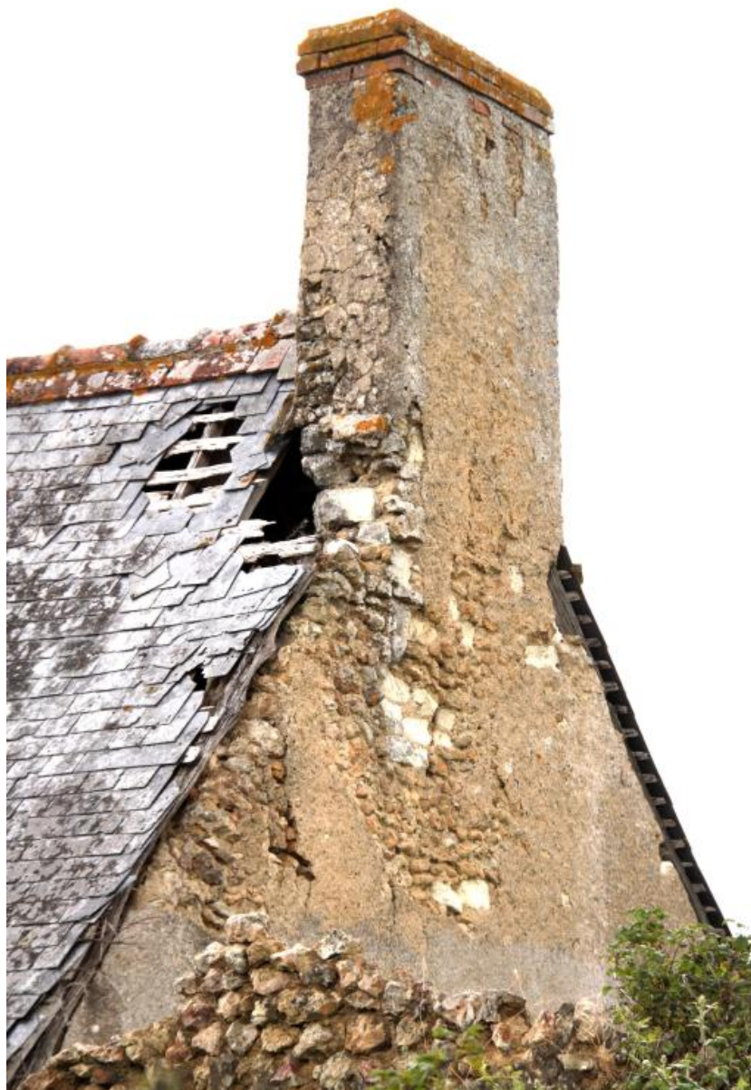
Maison : détail de la souche de la cheminée.
