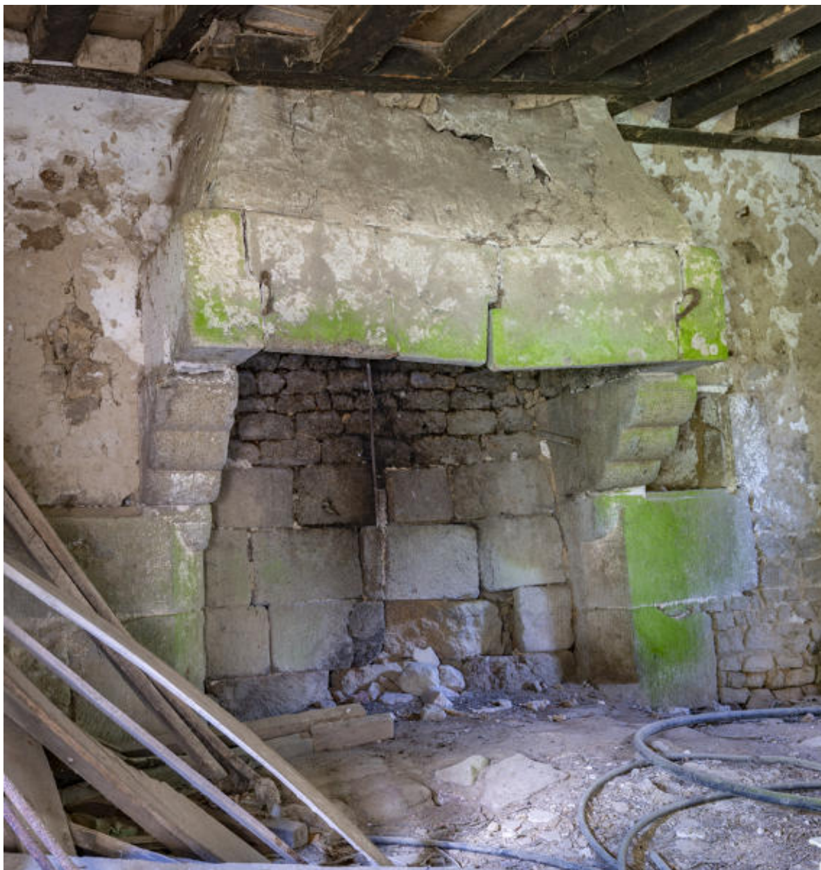
La cheminée du rez-de-chaussée.
