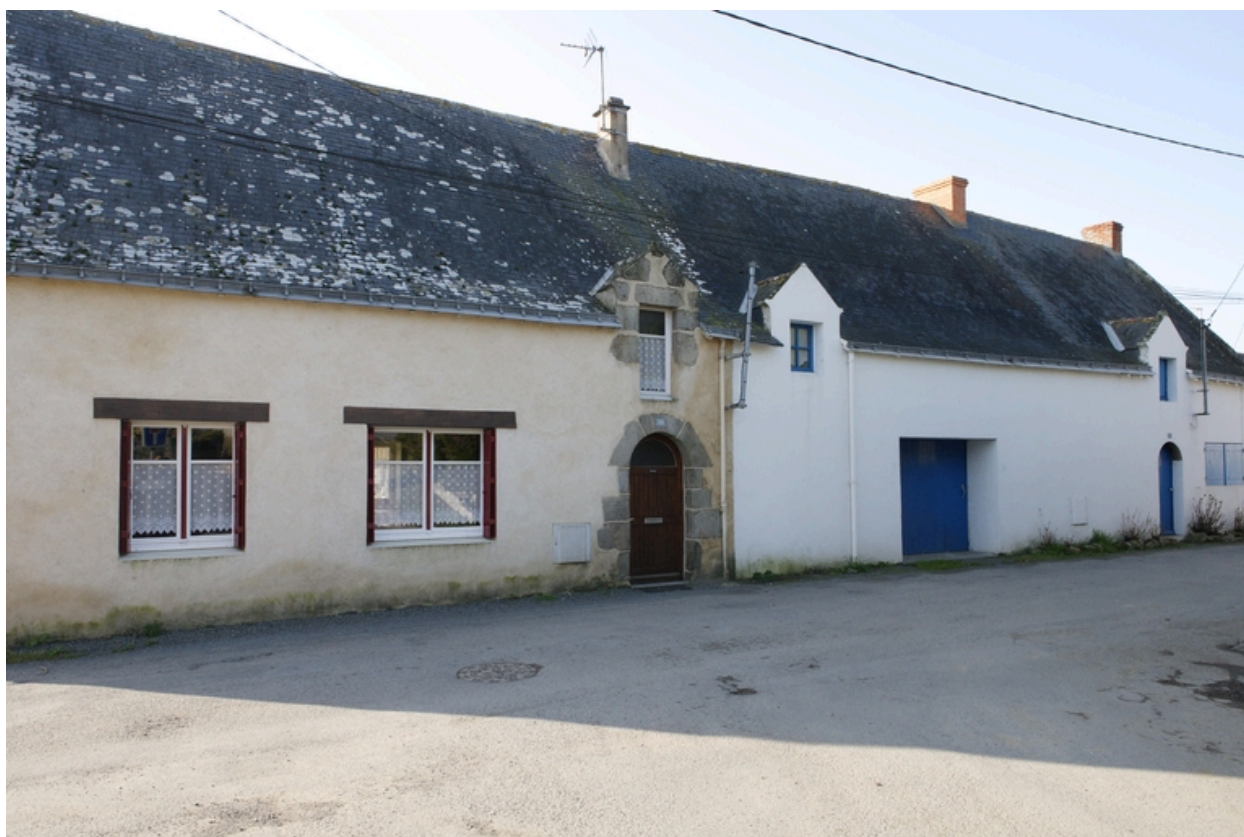
Vue de la façade nord.
