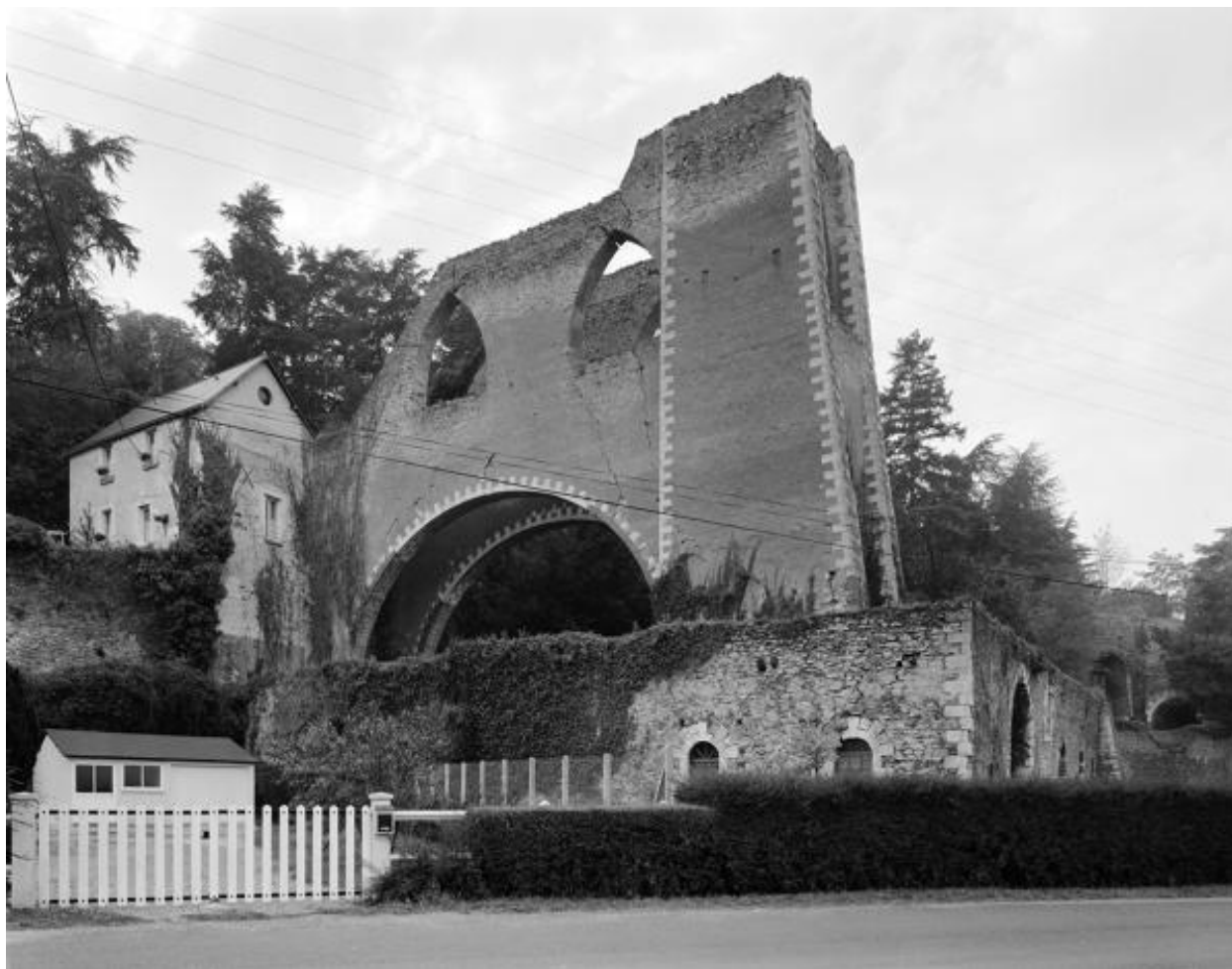
Vue du profil du chevalement du puits de la Tranchée depuis l'est.
