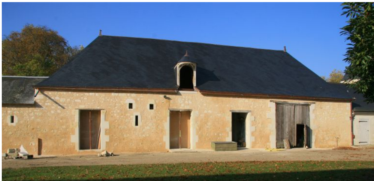
Façade est de l'orangerie devenue écuries.
