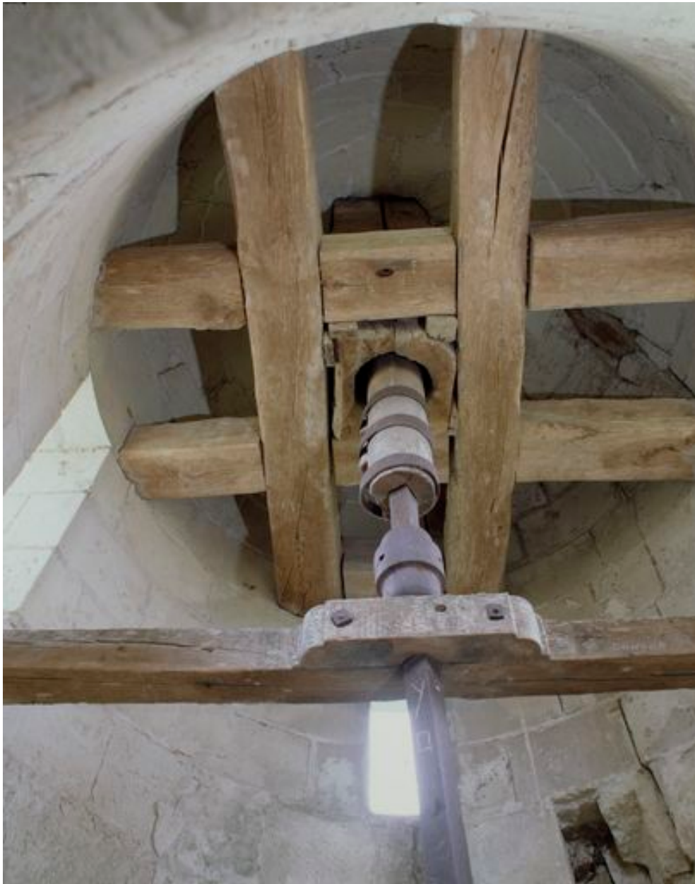
Le mécanisme du moulin, gros fer et racinaux (en 1991).
