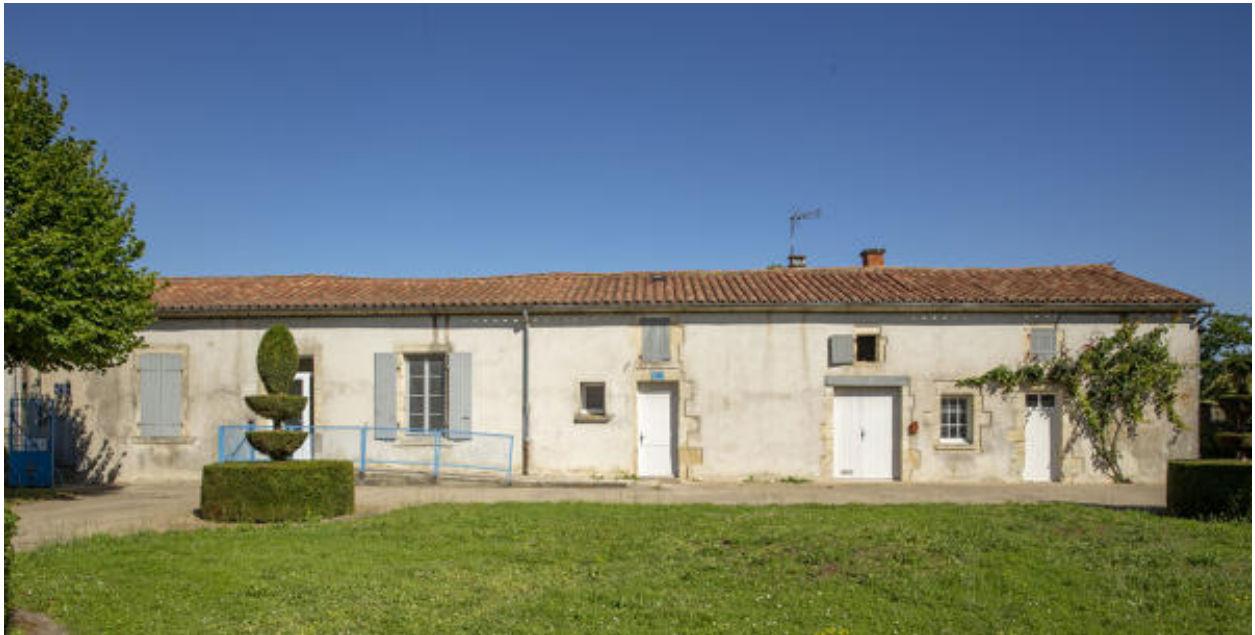
L'aile nord-ouest vue depuis le sud-est.
