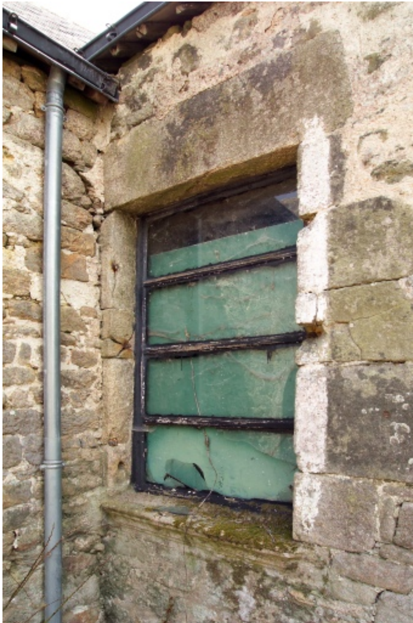
Bâtiment sud, détail fenêtre.
