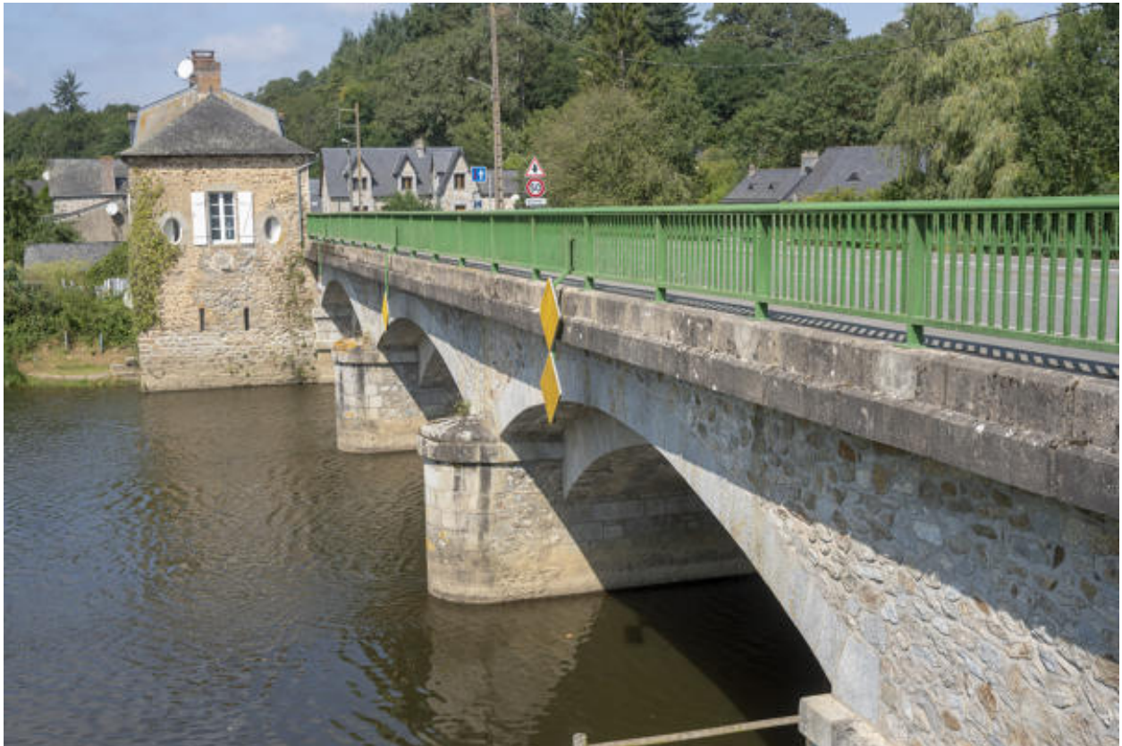
Le pont de Montgiroux.
