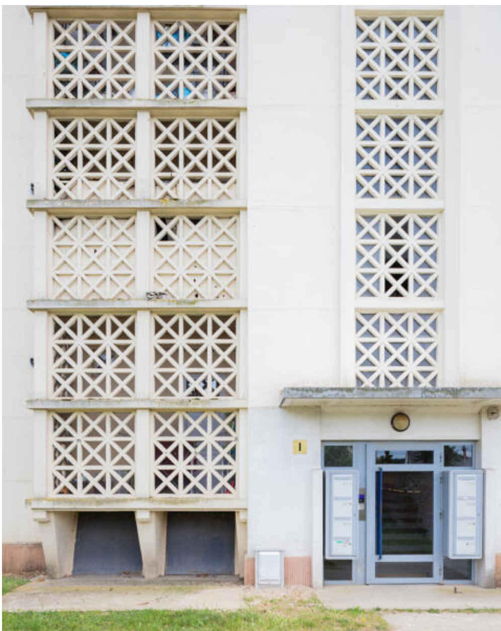
Détail du béton moucharabieh sur la travée centrale du bâtiment A.
