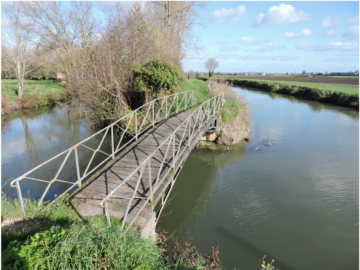
La passerelle sud-ouest vue depuis le sud-ouest.
