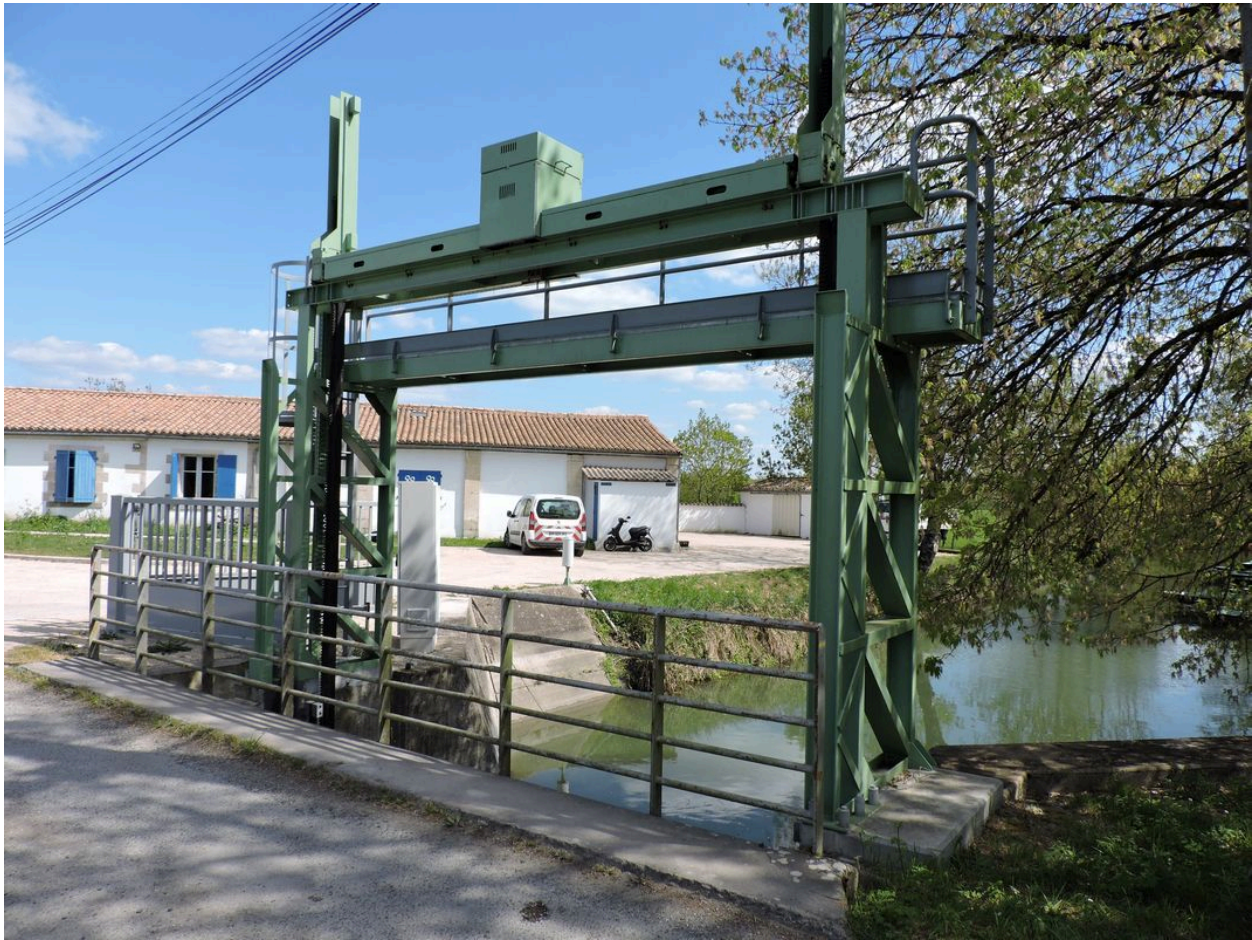
Le portique côté aval.
