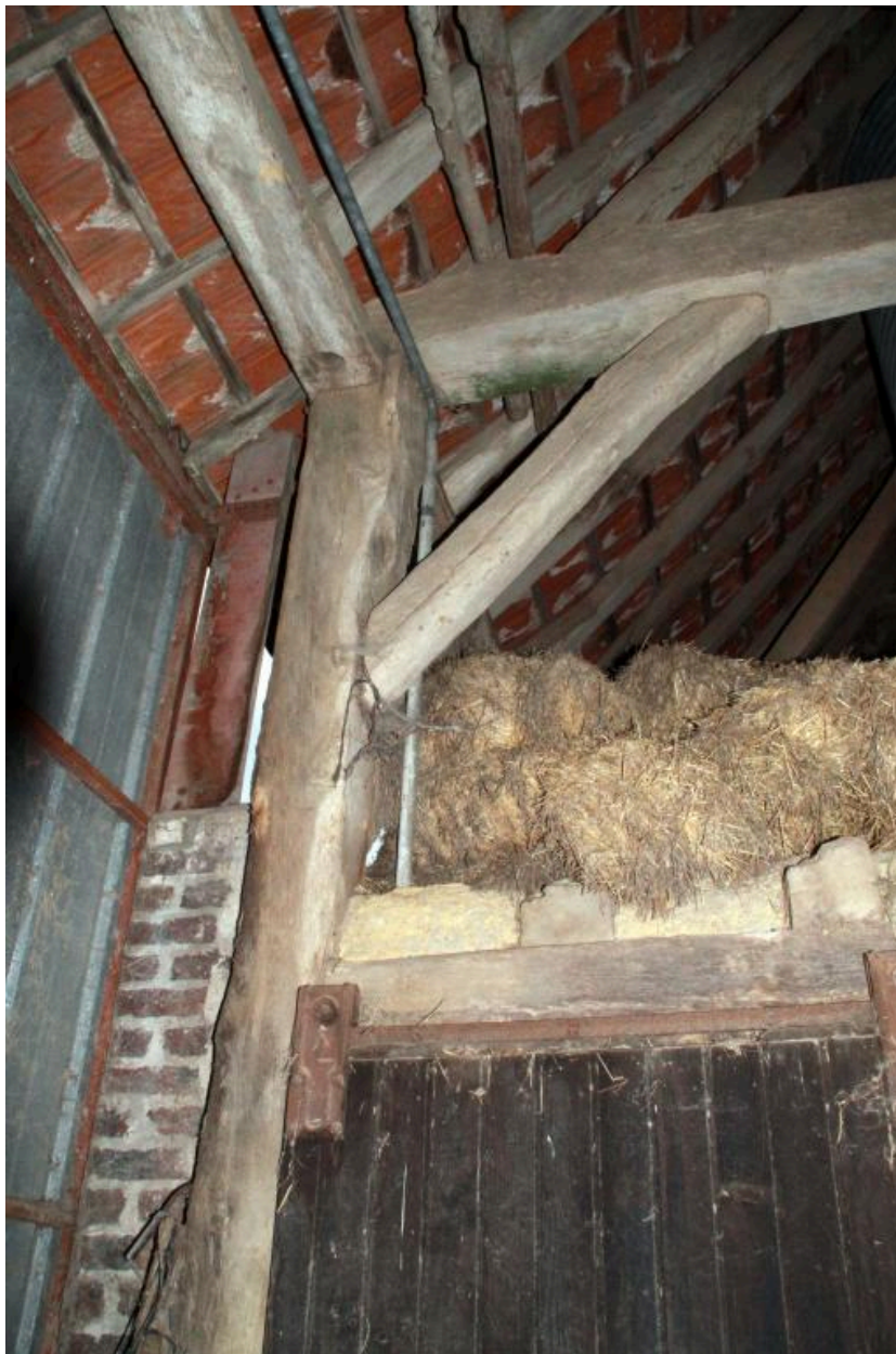
Grange-étable, intérieur grange : poteau cornier et structure en bois.
