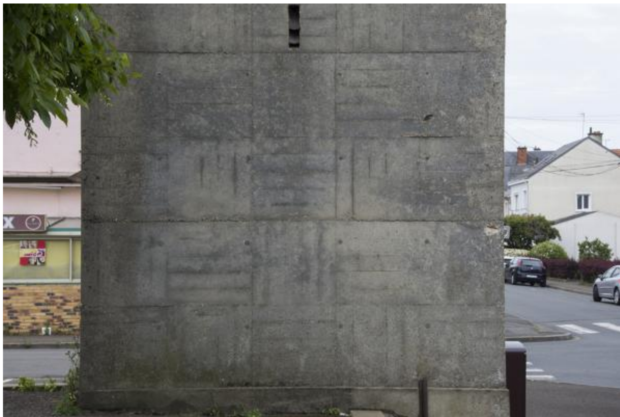
Vue du coffrage béton sur le campanile.
