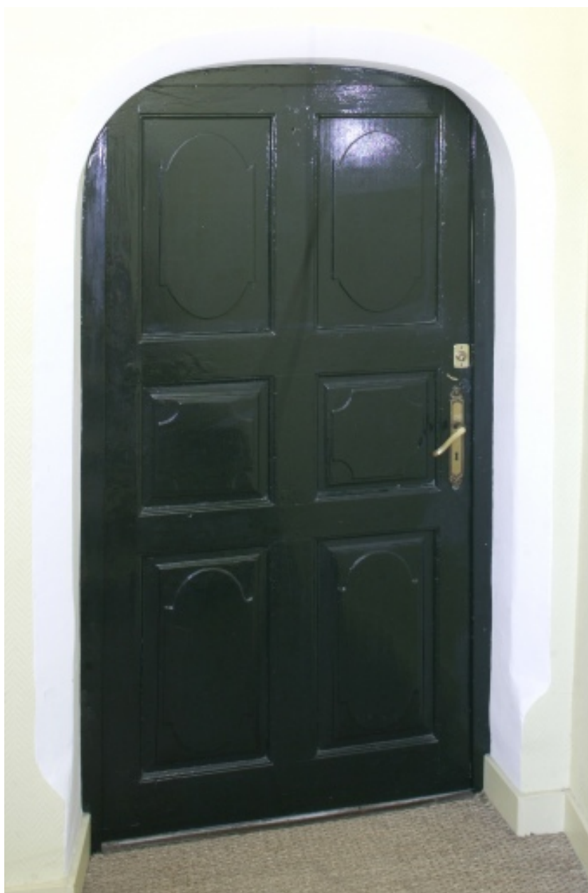
Menuiserie XVIIIe siècle dans la cage d'escalier au premier étage.
