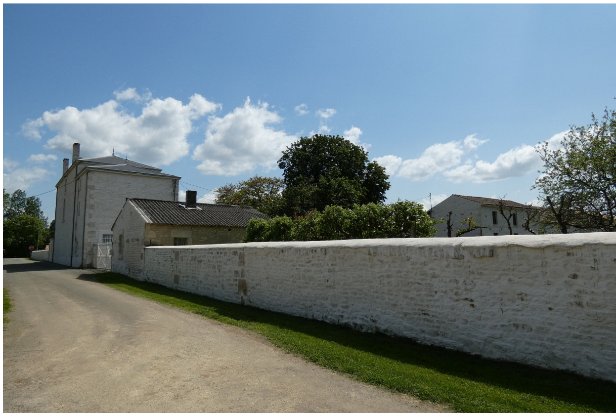
La propriété vue depuis le nord-ouest.
