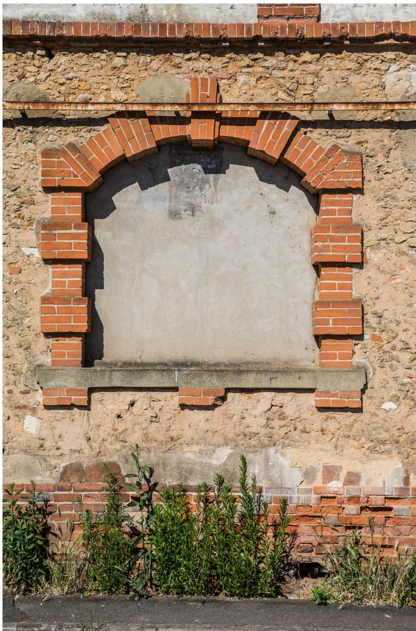
Une baie du mur-pignon de l'usine.
