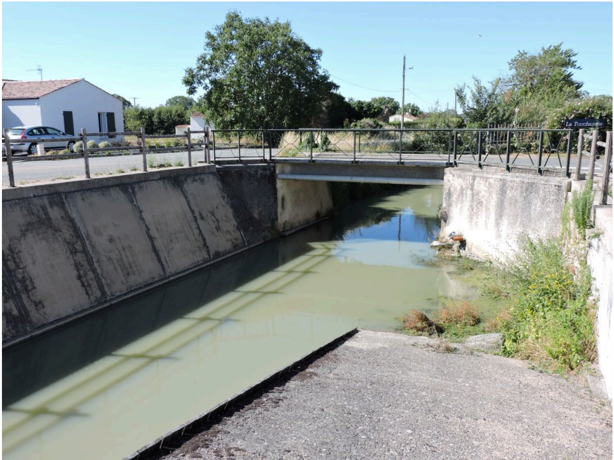
Le pont vu depuis l'amont, au nord.
