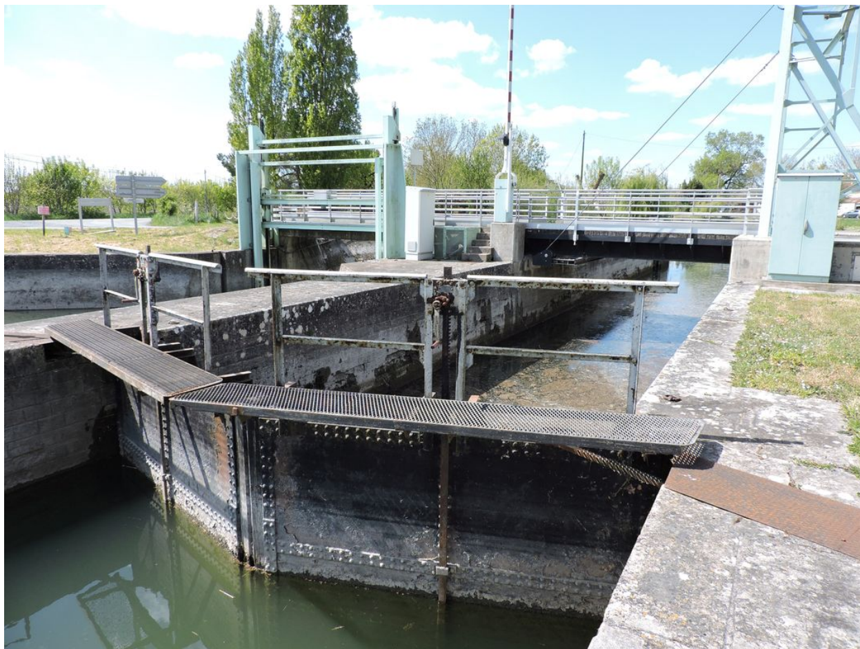
Le sas et la porte amont de l'écluse vus depuis l'amont, rive droite.
