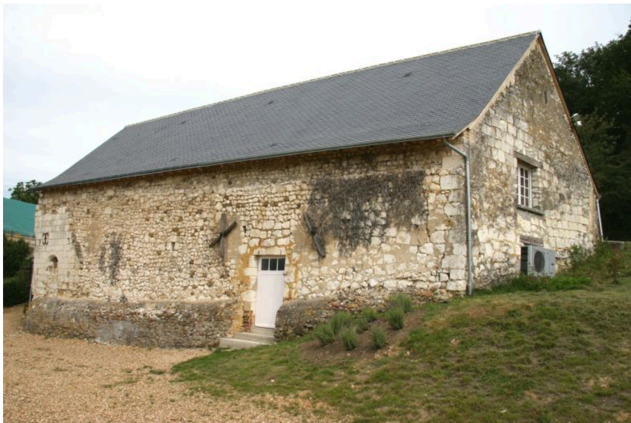
Logis 2 : vue de volumpe prise du sud-est.
