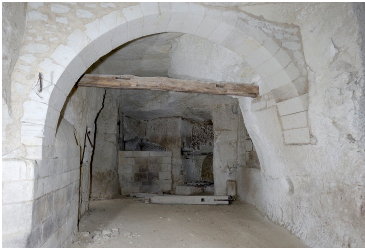
Champfleury : caves, avec probables vestiges du perroquet d'un pressoir à roue (2).
