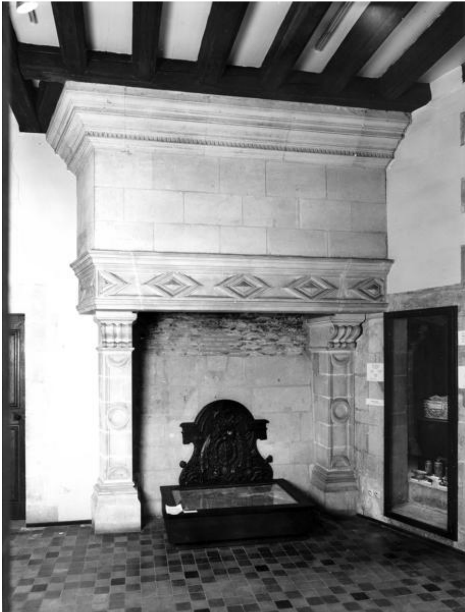
Corps de logis droit, rez-de-chaussée, pièce postérieure, mur postérieur : cheminée.
