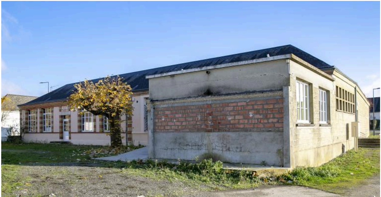
Le bâtiment des classes et la cantine.
