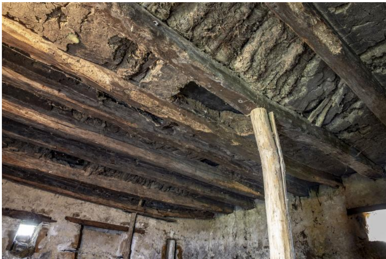
Vue du plafond du rez-de-chaussée de l'appenti de la grange.
