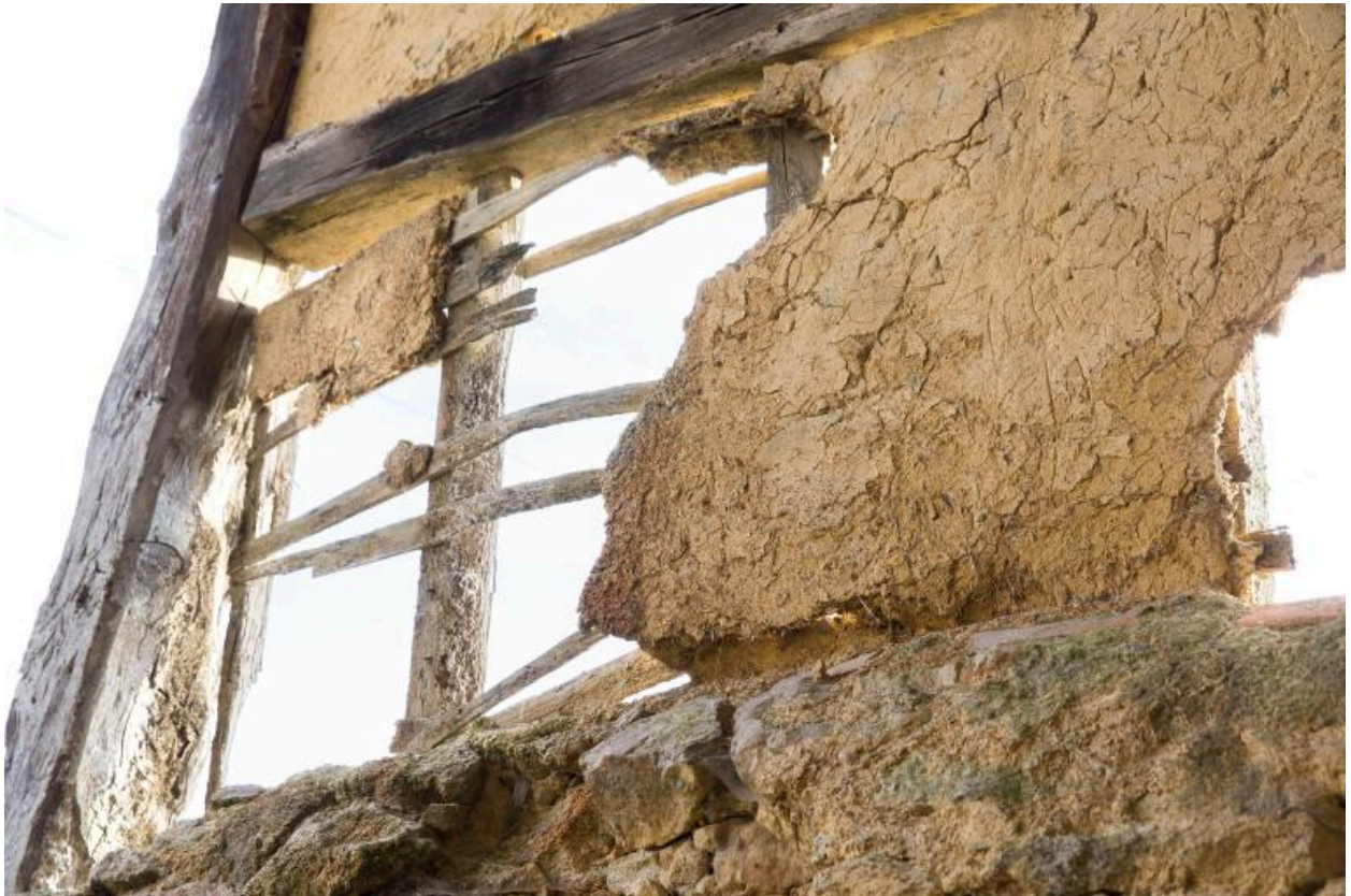
Bâtiment avec cloison en torchis (détail). La Mauvillonnière, La Planche, cadastre 2018, YA 01-187
