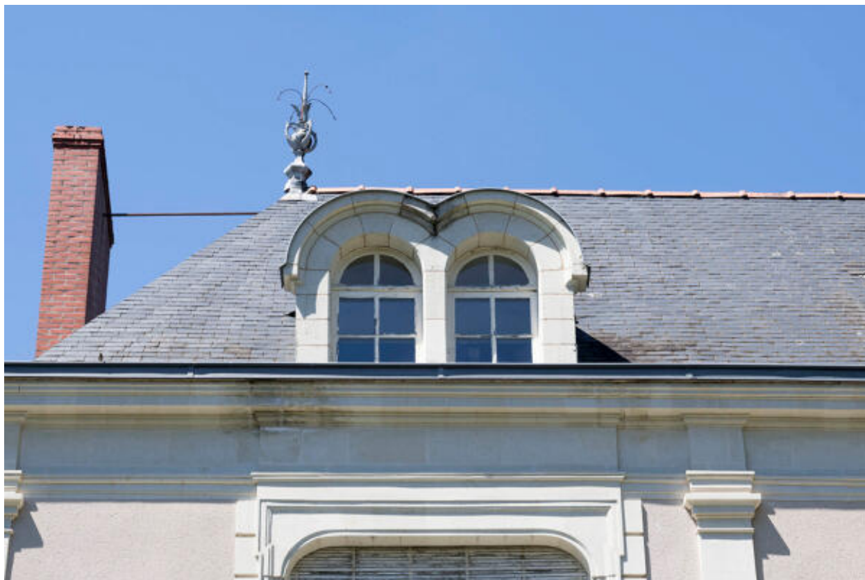
Façade est. Détail de la lucarne géminée sud.
