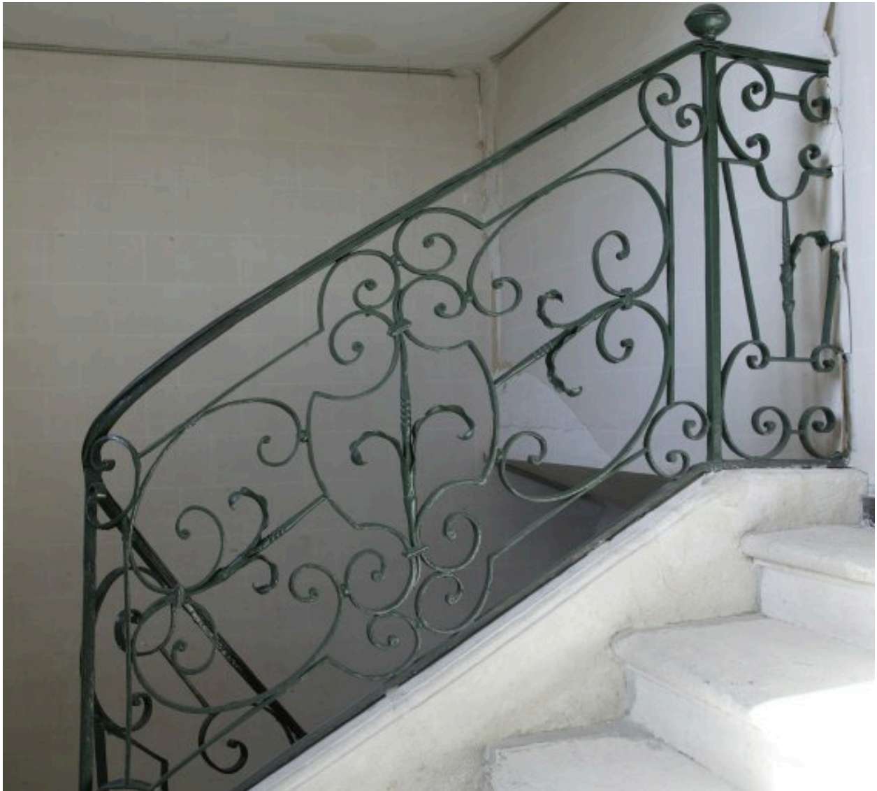
Détail du garde-corps de l'escalier.
